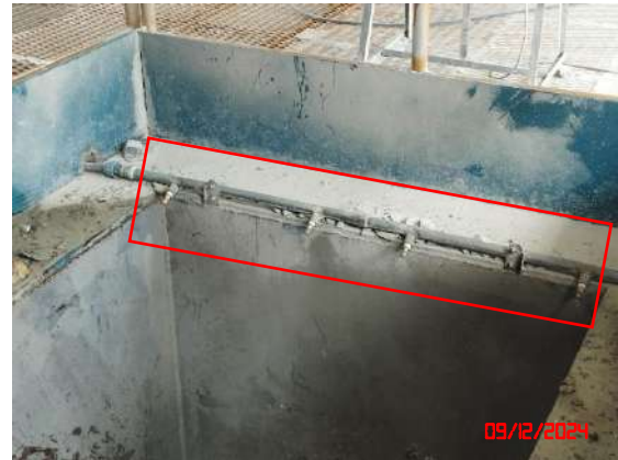
รูปที่ 6 ระบบสปรύνน้ำภายในโรงโม่หิน
