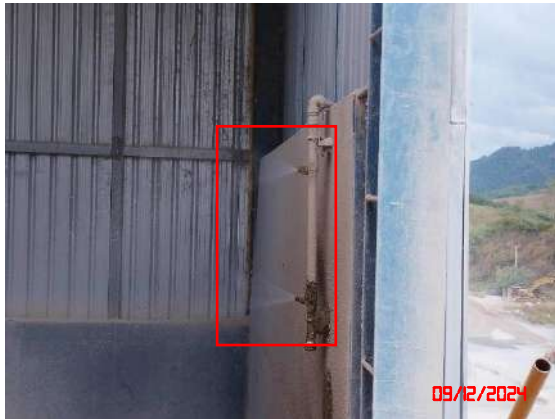
รูปที่ 6 ระบบสปรύνน้ำภายในโรงโม่หิน
